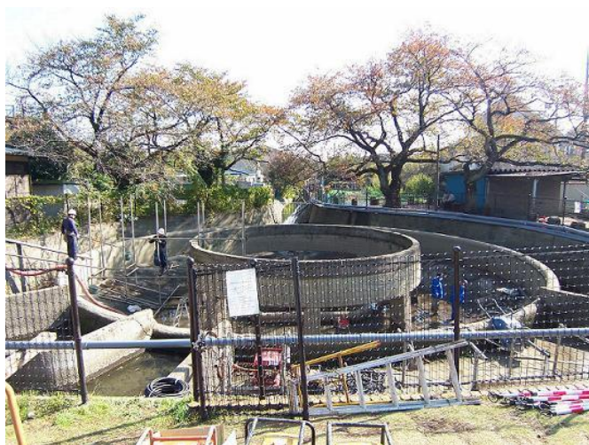
▲現在は修復工事中。桜が咲く頃には綺麗に整備されることでしょう
