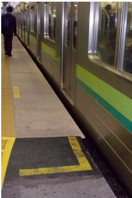
▲段差と隙間の解消工事が進むホーム
